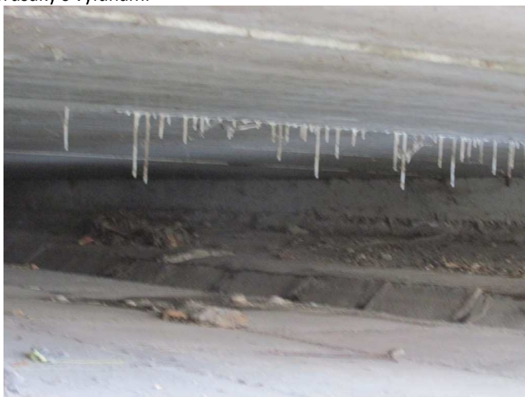
26) NK1 v podhledu / průsaky s výluhami
