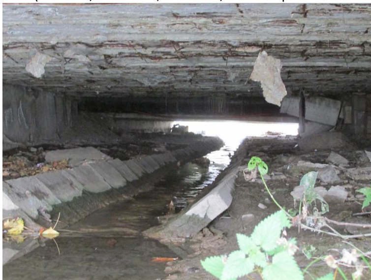
20) NK2 pohled od vtoku – cca v ½ šířky mostu navazuje NK1, zároveň mezi konstrukcemi velkopřůměrová chránička inženýrských sítí (vodovod, kanalizace, horkovod, nebo tak podobně – nebylo zjišťováno)
