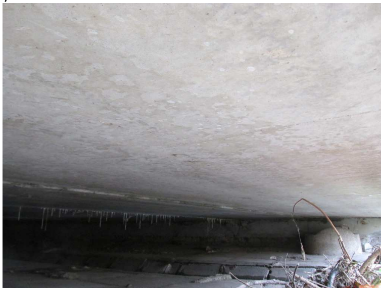
26) NK1 v podhledu / průsaky s výluhami
