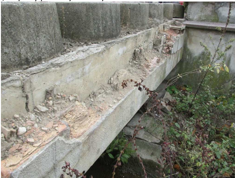
23) NK1 – detail zprava / odpadlý přizdžený líc římsy
