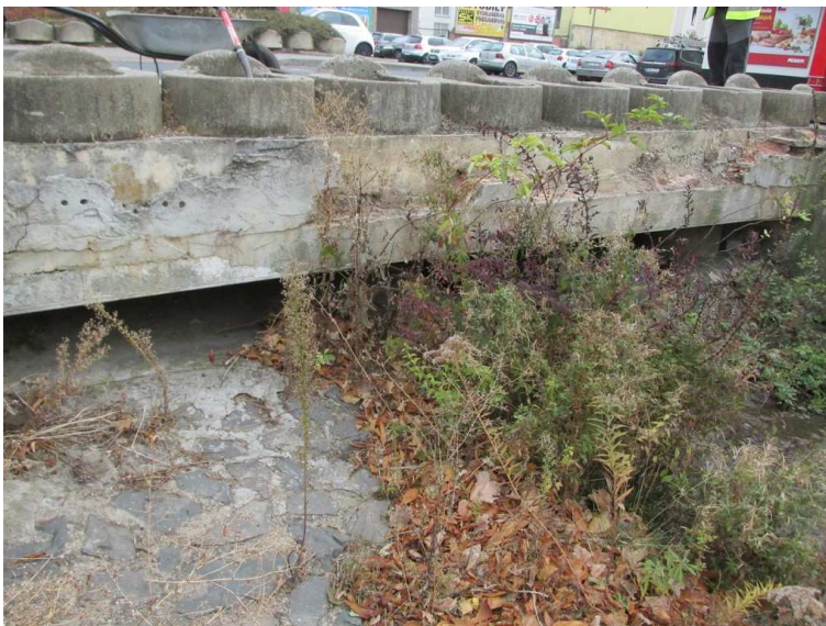
23) NK1 – detail zprava / odpadlý přizdžený líc římsy
